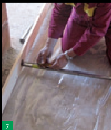
4 Montáž horní lišty s kolejničí
