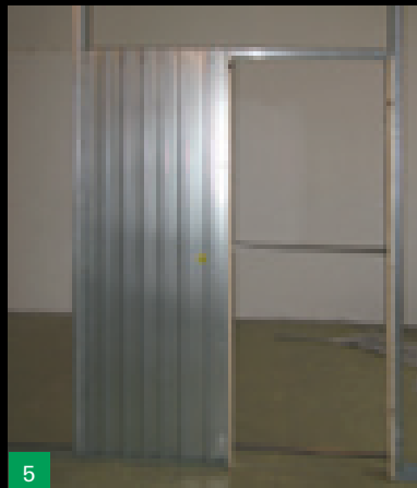
5 Usazené a zabudované pouzdro v konstrukci
