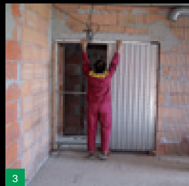
Vyvážení pouzdra horizontálně
